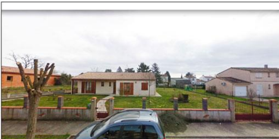
PCMI7 - Photographie du terrain dans son environnement proche
